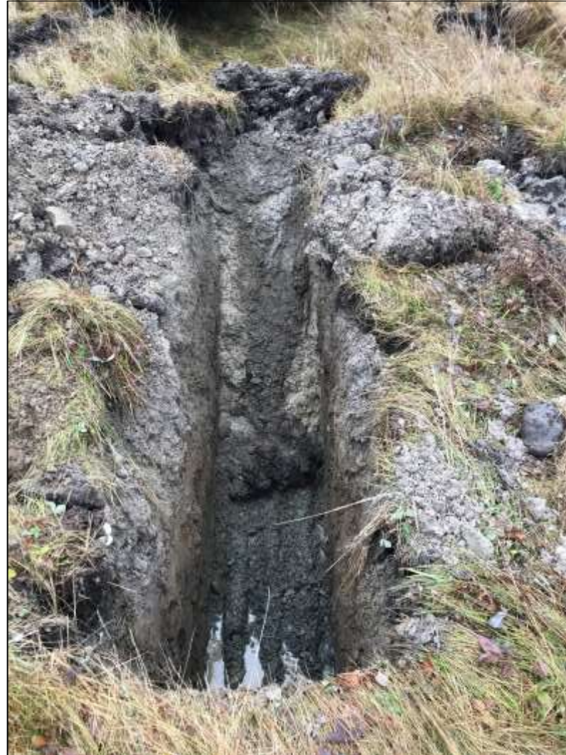
PHOTO # 10 Puits d'exploration PE-9-18; Terrain naturel: Sols organiques; Silt et sable, un peu de gravier; Shale Venue d'eau moyenne à 1,20 m
