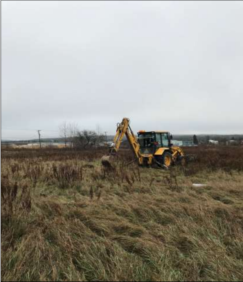
PHOTO #1: Emplacement PE-1-18 Coin nord du terrain
